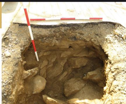
Základ hřbitovní zdi u kostela sv. Prokopa.
