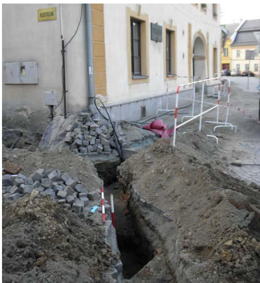
Profil P2, celkový pohled od JV.
