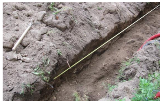
Detail odhalené koruny lícovaného zdiva (č.108)
