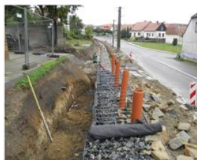
Zkoumaný profil s vrstvami a objekty z pravěku až novověku.
