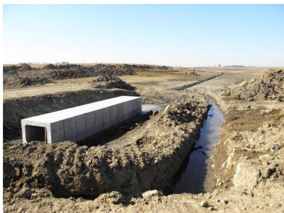
Moravské Budějovice, Pod Ochozem, stavba hráze od V.
