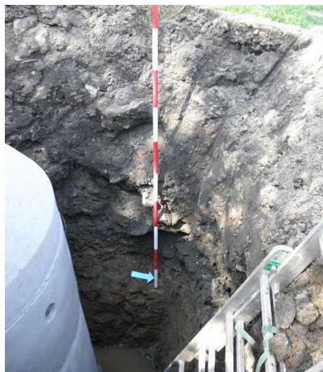
Přibyslavice, kanalizace. Profil P2 – pohled od V
