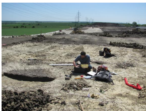
Sedimentační nádrž K4 a ČOV v areálu cukrovaru Dobrovice
