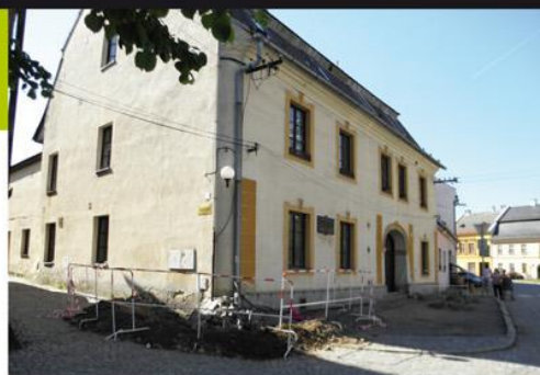
Pohled na zkoumanou lokalitu na náměstí.
