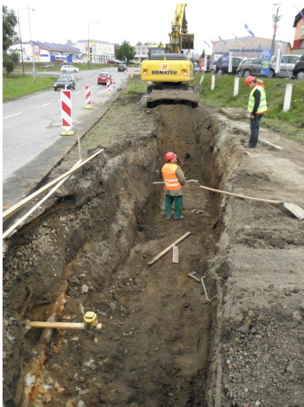
Třebíč, ul. Hrotovická, celkový pohled od J.
