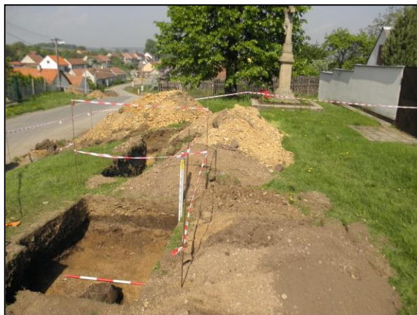
Celkový pohled na výkopové práce.
