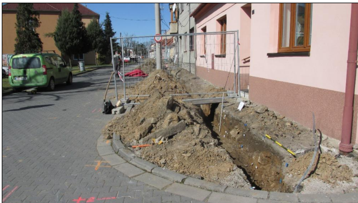
Obr. 1. Výkop vedený při severní straně návsi. Pohled od východu. Foto: Petr Mudra
