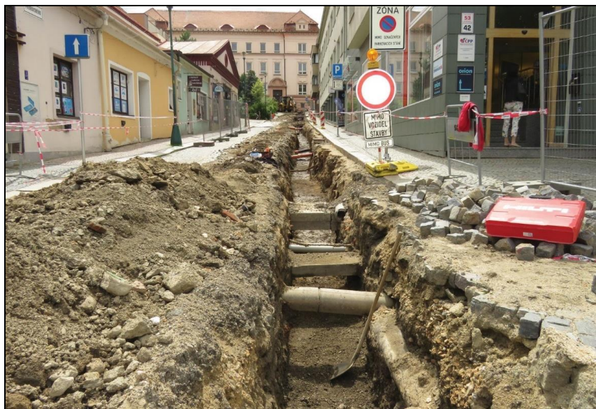
Obr. 2. Výkop pro teplovodní rozvody vedený ulicí Přerovského. Pohled od severu (od Karlova náměstí). Foto: Petr Mudra
