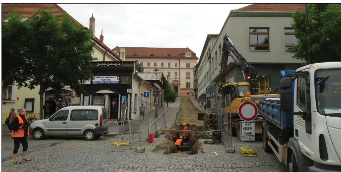
Obr. 1. Výkop pro rekonstrukci kanalizace vedený ulicí Přerovského. Pohled od severu (z Karlova náměstí). Foto Petr Mudra
