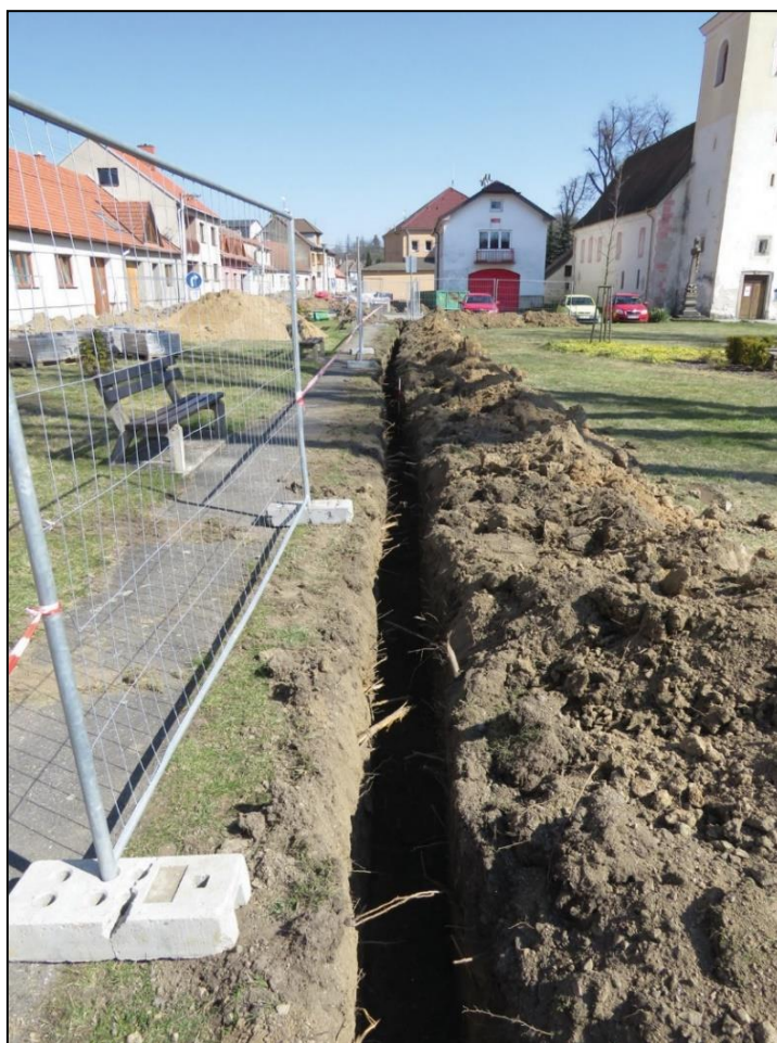
Obr. 2. Výkop vedený středem návsi. Pohled od západu. Foto: Petr Mudra
