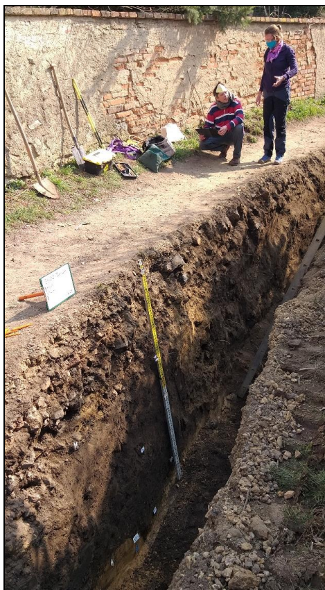
Obr. 1. Výkop pro inženýrské sítě vedený ulicí Ke statkům. Foto: Pavel Hušták
