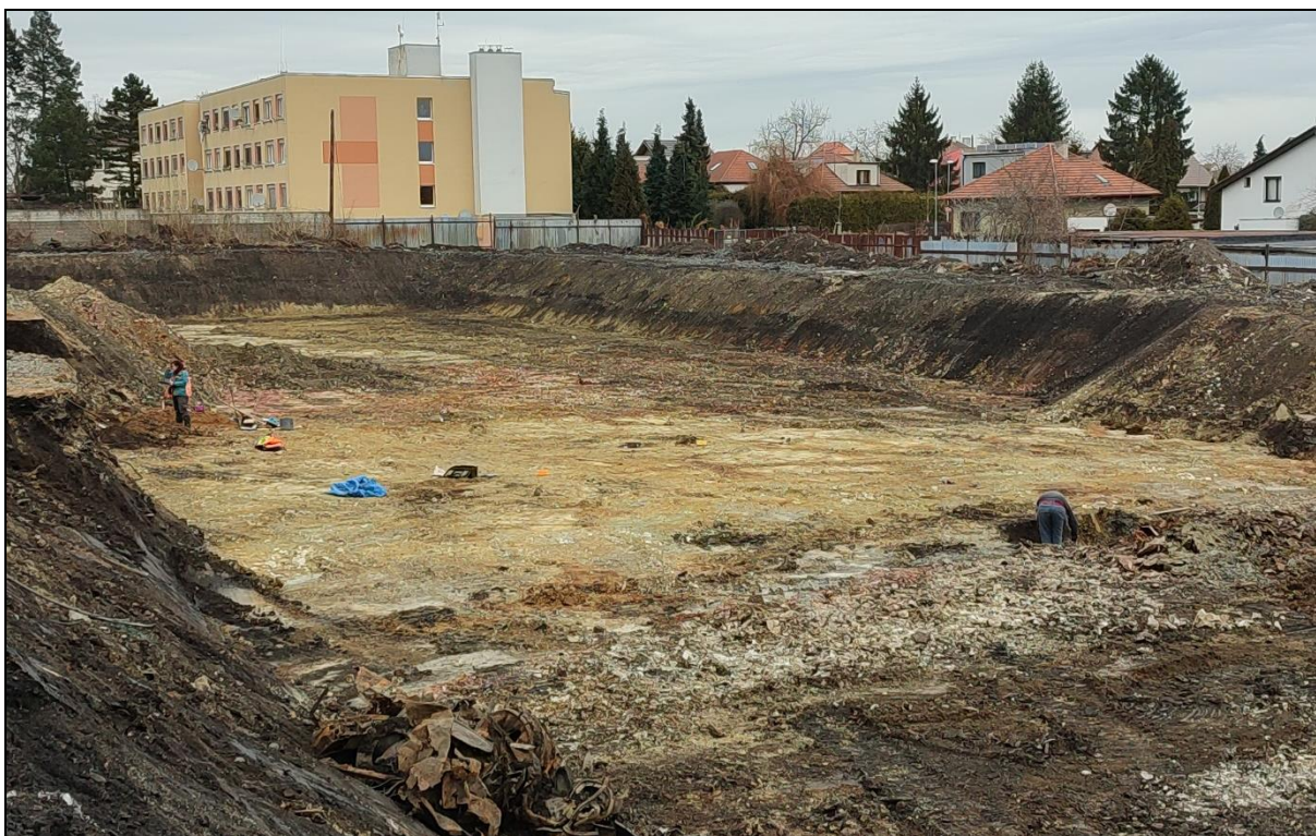
Stav po skrývce lok. Brandýs nad Labem, soubor bytových domů (ul. Augustina Lukeše) Zdroj: dokumentace Pueblo – archeologická společnost, o. p. s.
