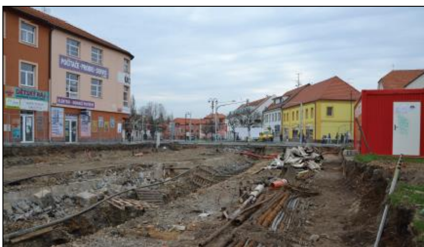
Náměstí po odtěžení povrchu komunikace a části terénu. Je zjevné, že prostor byl do velké míry porušen recentními zásahy, zejména kolektory pro inženýrské sítě. Pohled od jihu. Foto: H. Hrušková
