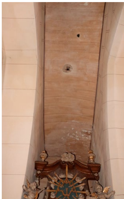
| Pohled do původně volného průhledu do gotické věže. Segmentová klenba pochází z úprav druhé poloviny 19. století. Nad ní se nachází relikt záklopu staršího, ale dodatečného plochého přestropení prostupu (2025)
