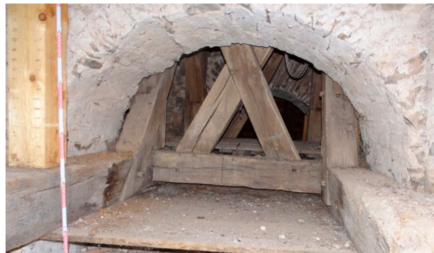
Pohled do prostoru mezi východním štítem lodi nad triumfálním obloukem a pasem vloženým do východní části lodi. Po levé straně je viditelný dřevěný konstrukční prah z doby po polovině 16. století vynášející dodatečně vloženou roštovou konstrukci ve věži (v pozadí). Zřetelný je relikt spodního záklopu plochého přestropení původně volného průhledu do věže (2025)
