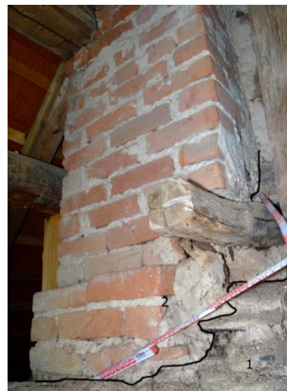
Pohled na zachované středověké táhlo pod záklenkem západního otvoru ve věži (2025)
